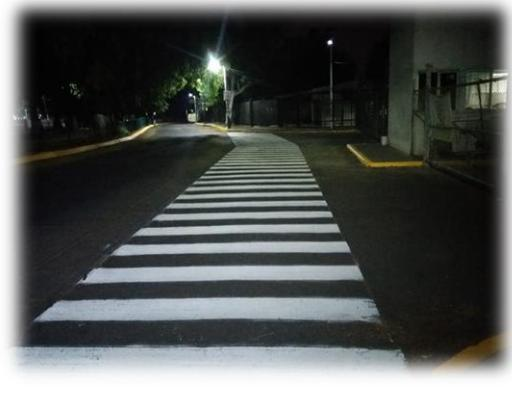
Balizamiento de señalamiento vehicular de 25 mts. lineales, señalamiento peatonal 250 mts. Y señalamiento de guarniciones de 914 mts. Lineales, señalamiento vertical en Río Bamba, con la colocación de 6 piezas forjadas y flejadas con indicación de No Estacionarse.
