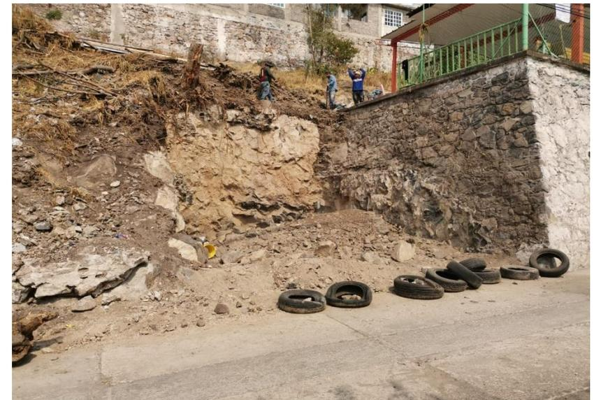
Excavación y retiro de material producto de excavación, mediante medios manuales
