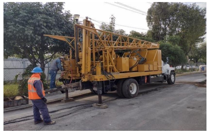
Se observa el panorama general del área de trabajo, se realizaron los trabajos de perforación, ejecución de ensayo SPT, trabajos de perforación de pozo a cielo abierto a cielo abierto.
