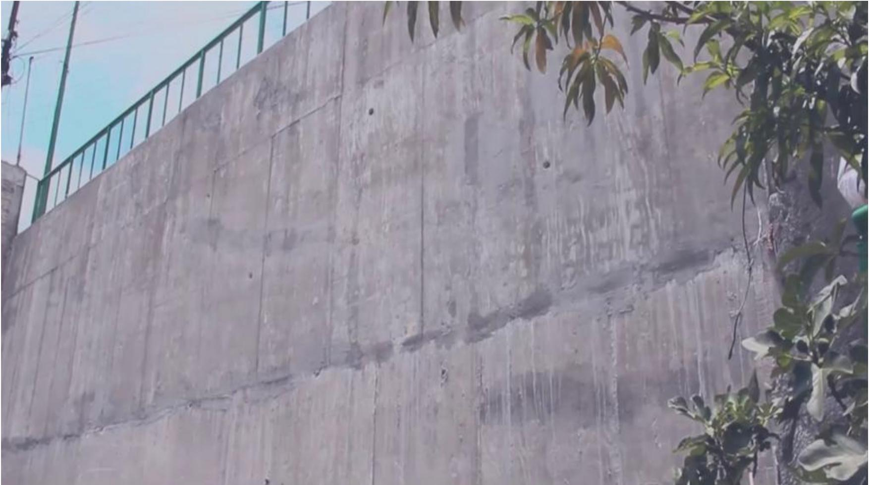
Muro de contención de concreto armado terminado en Av. La Brecha
