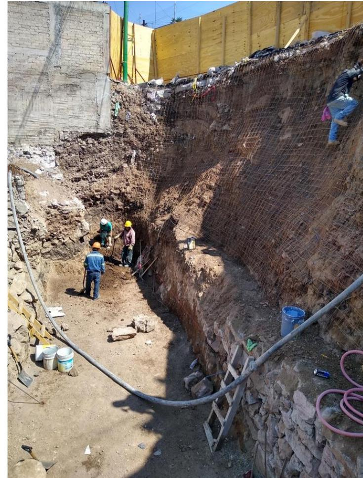
Excavación para inicio de los trabajos del muro de contención
