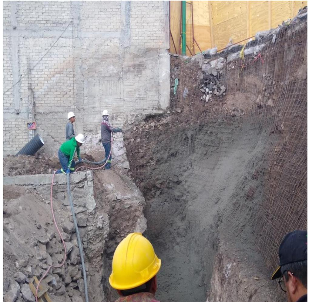
Lanzado de concreto para estabilizar el talud
